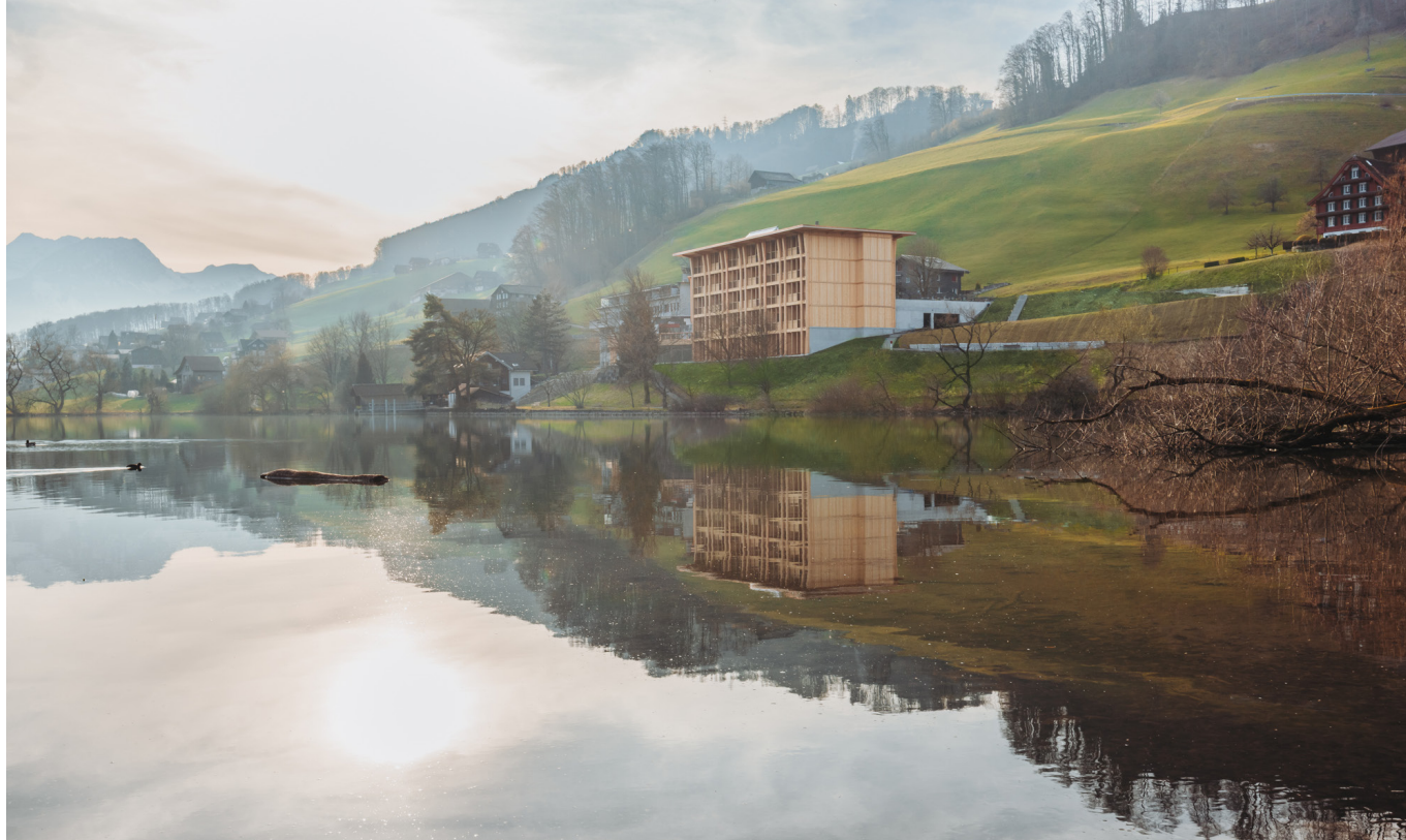
Der neue Erweiterungsbau des Hotels Kurhaus am Sarnersee wurde an das modernisierte Bestandsgebäude (links davon) angedockt.
