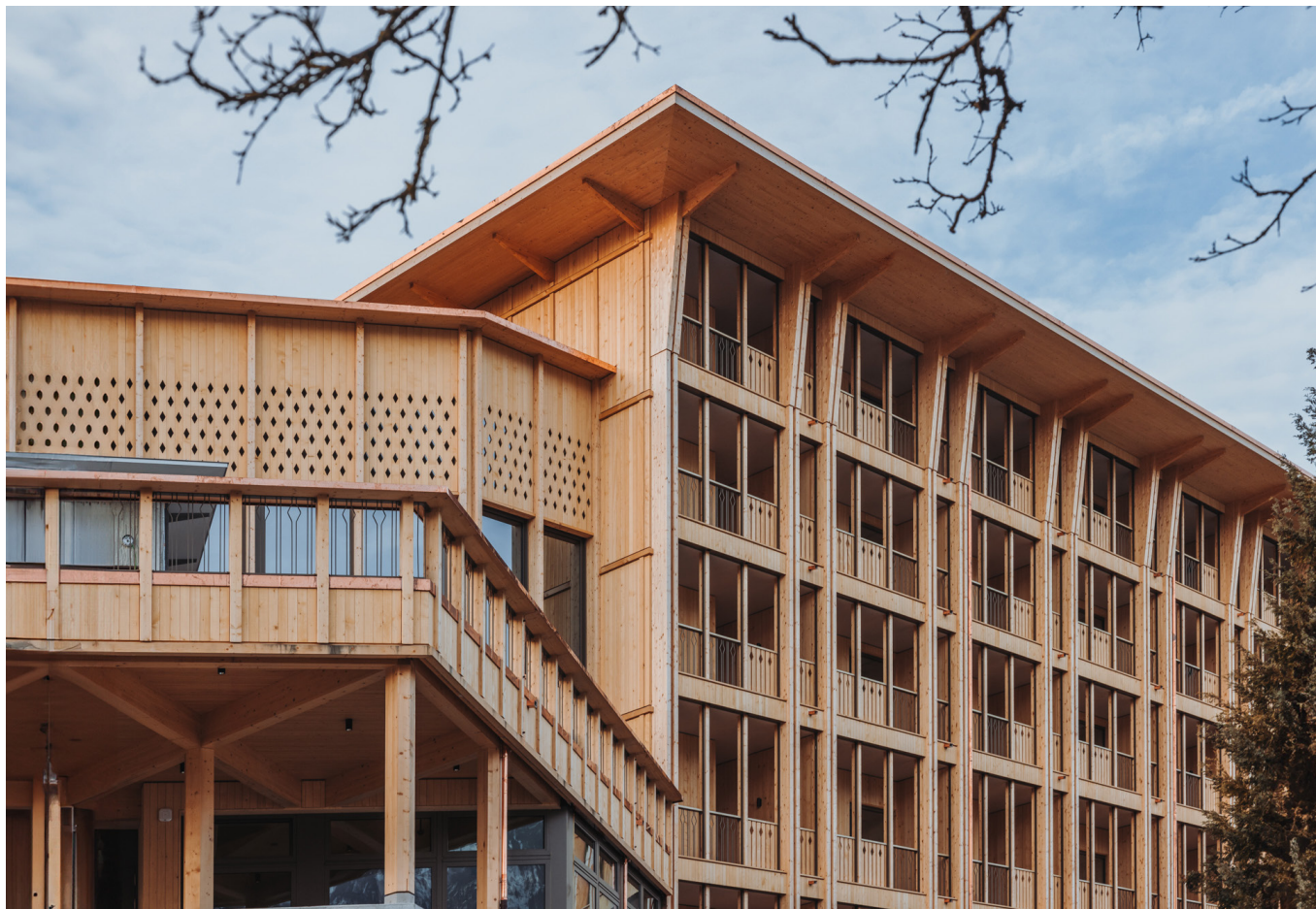
Links der neue dreigeschossige Mittelbau, rechts der fünfgeschossige Neubau mit 30 zusätzlichen Zimmern. Die Doppelstützen bilden prägnante Gestaltungselemente.
