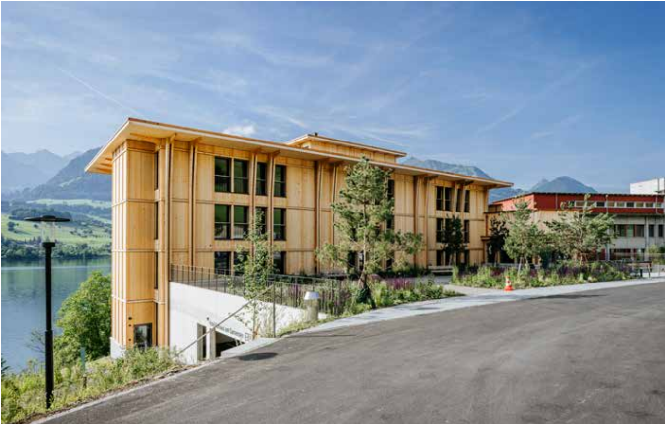
Bergseitige Fassade mit Ankunftssituation
