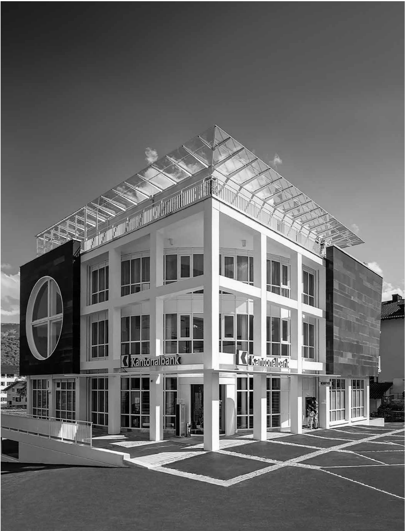
Nordwestfassade mit Haupteingang Bankfiliale
