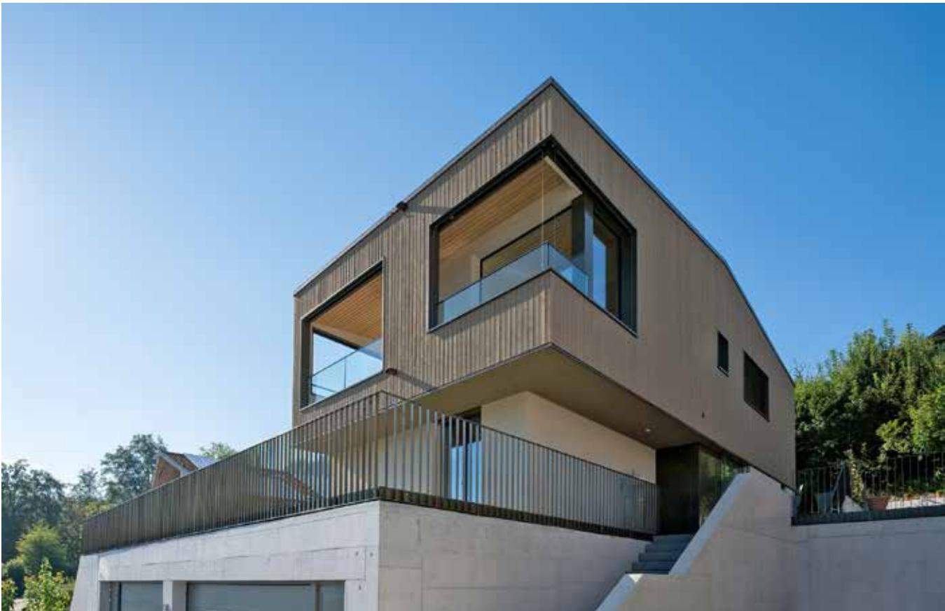
Zweigeschossiger Holzbau auf Garagengeschoss
