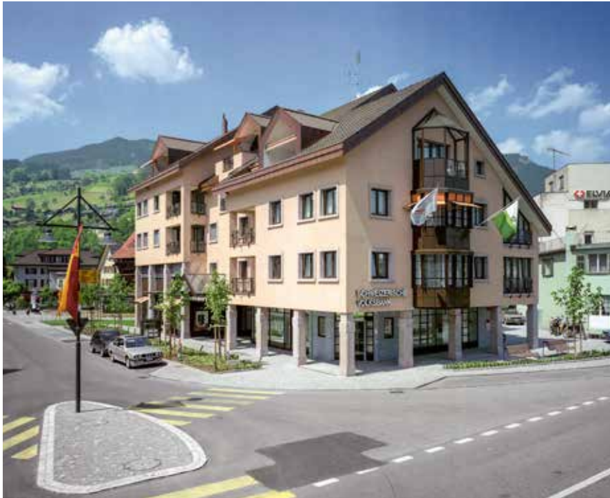
Blick vom Bahnhofplatz, Süd- und Ostfassade
