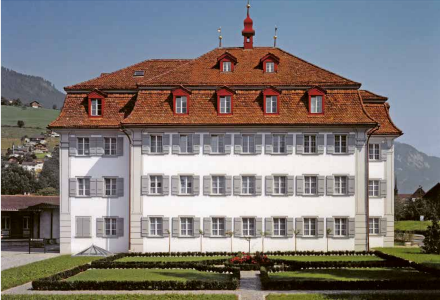
Südfassade altes Kollegium, erbaut 1751 von Jakob Singer im Barockstil
