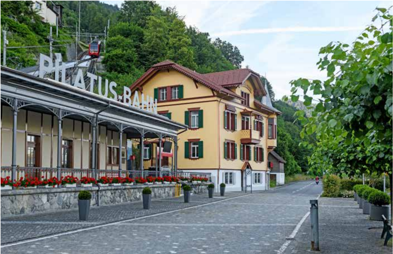
Sanierung historische Bausubstanz
