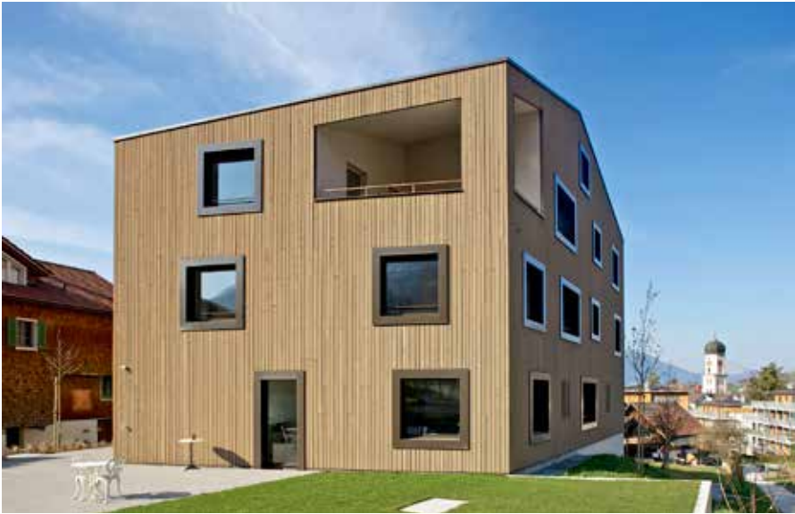
Moderne Holzfassade mit Fensterzargen in Metall
