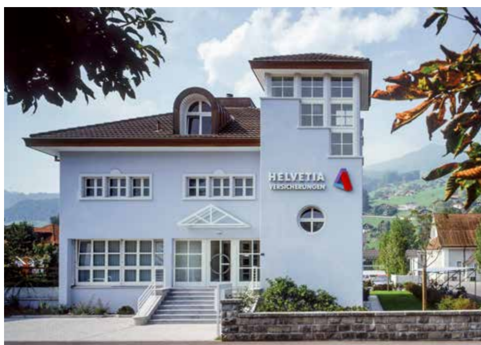
Ostfassade zur Brünigstrasse
