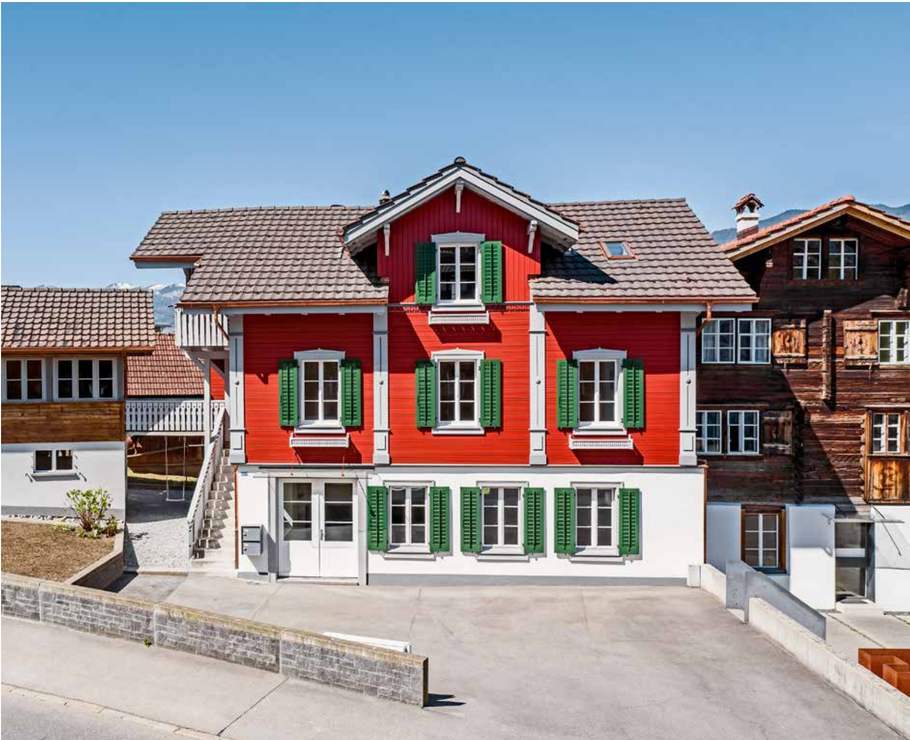
restaurierte Hauptfassade mit Nachbargebäude
